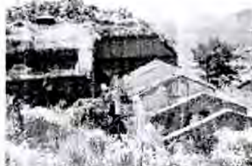
Stato dell'immobile dell'attuale sede della Scuola di Vela ante interventi di recupero
