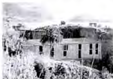
Stato dell'immobile dell'attuale sede della Scuola di Vela post interventi di recupero
